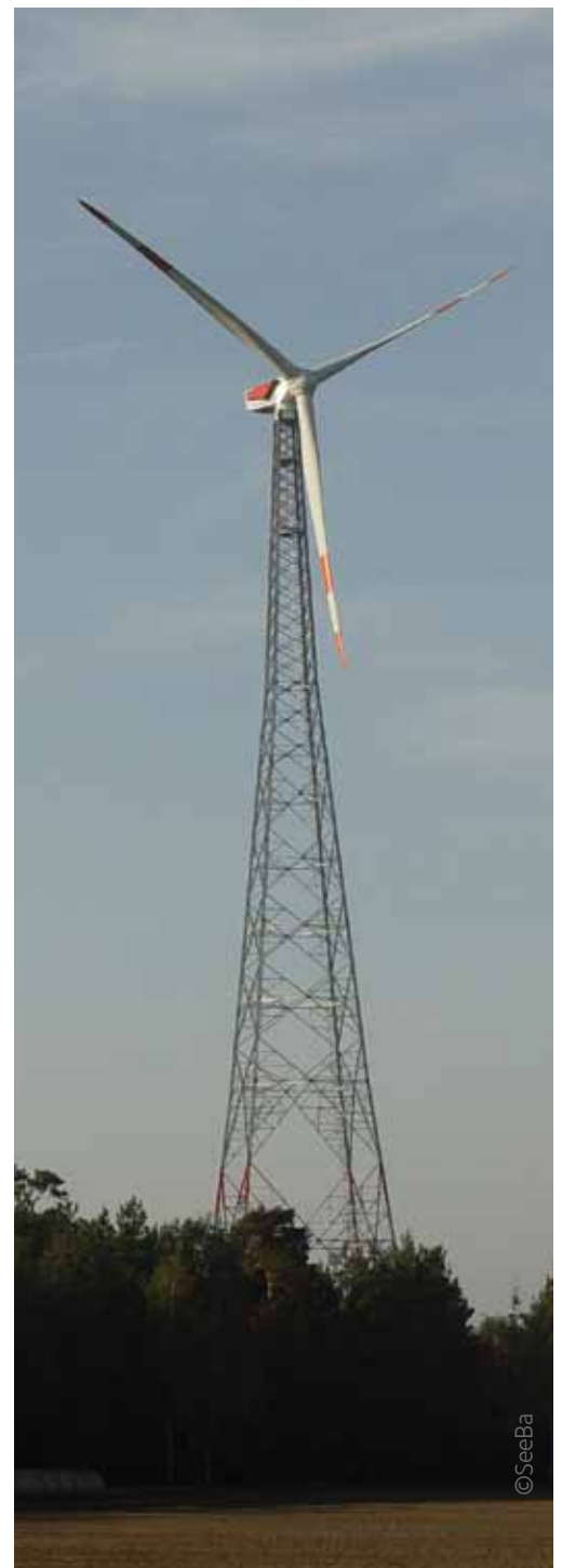
Abbildung 4: 160-m-Windturbine in Laasow (Fuhrländer)
