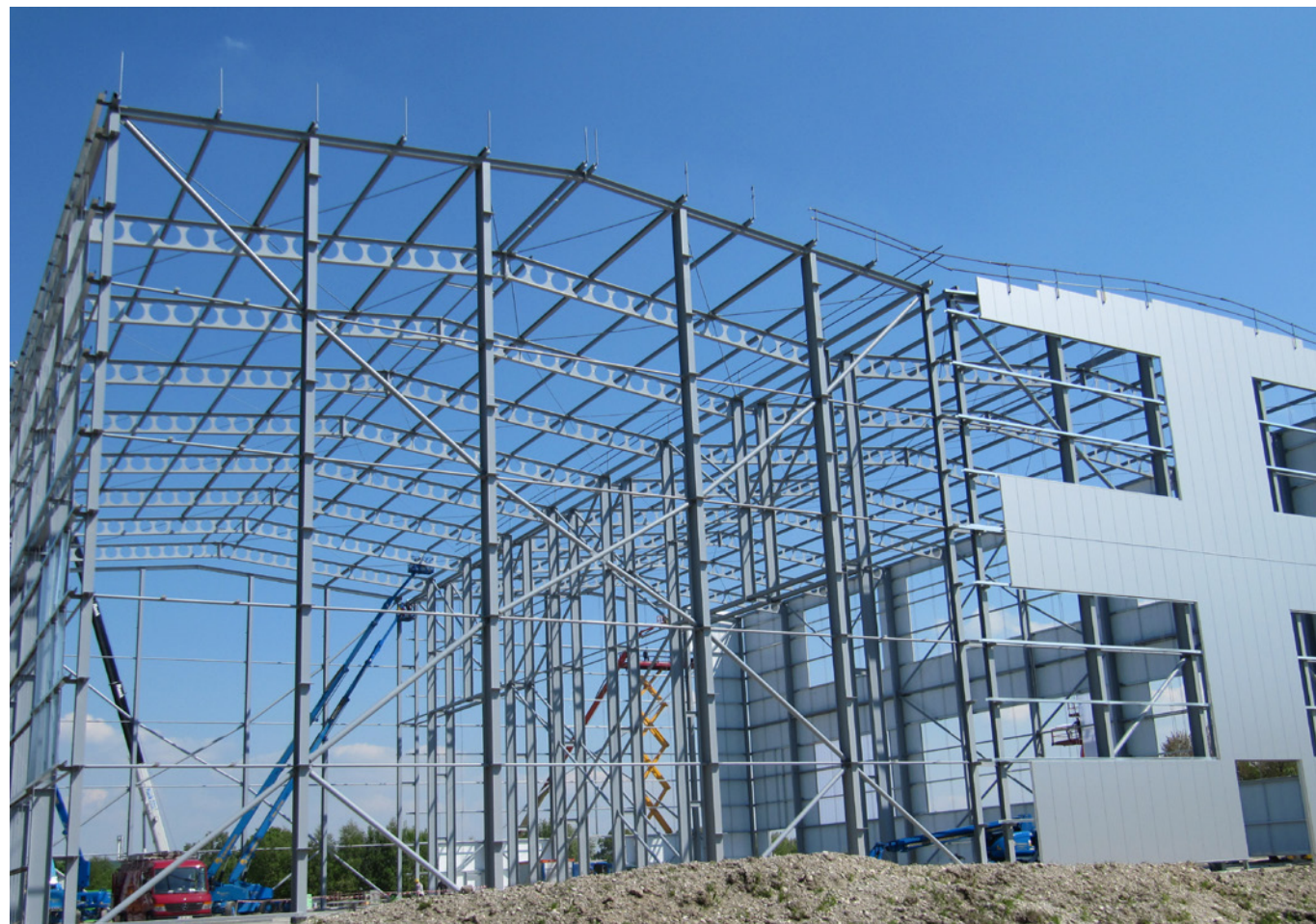
Mit Lochstegträgern kann nicht nur leicht, sondern auch stabil gebaut werden.
