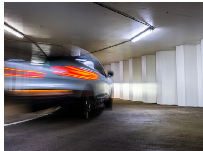
Stahlspondbohlen kommen in der Regel als Stützwände temporär oder permanent zum Einsatz, wie hier in einer Tiefgarage im belgischen Aalst.
